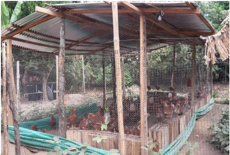
Galpón construido en el resguardo San José de Macarieros.
