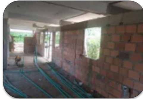
Instalación de tubería
