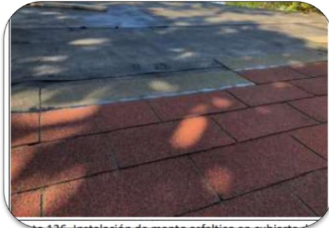
Instalación de manto asfáltico en cubierta
