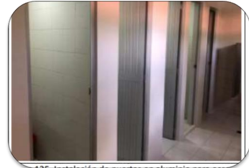
Adecuación de Baños Principales
