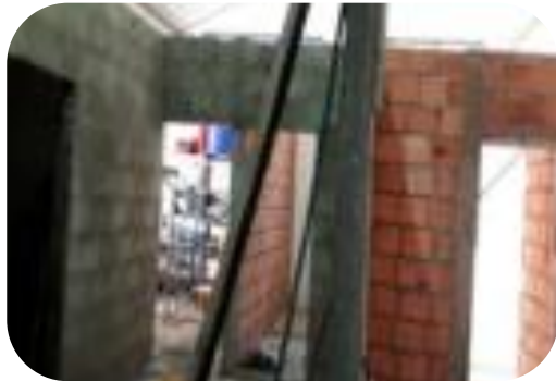
Construcción muros bloque No 4 Bienestar Universitario
