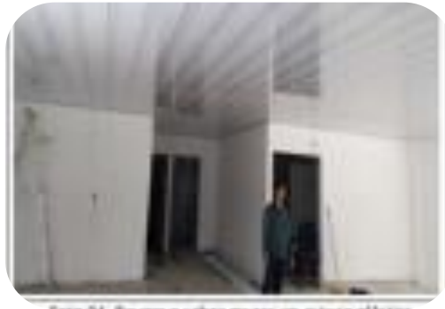
Instalación cielorraso Bienestar Universitario
