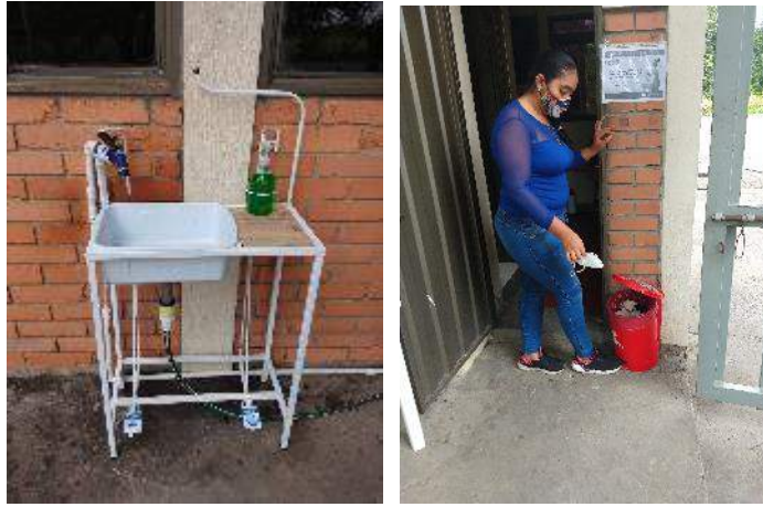
Figura 14. Instalación de lavamanos con pedal para minimizar el contacto. Disposición final de tapabocas como residuos con riesgo infeccioso.
