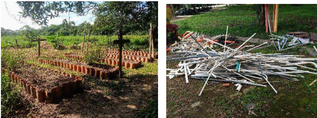
Figura 6. Separación (PVC) y aprovechamiento (tejas) de residuos provenientes de las obras de infraestructura.
