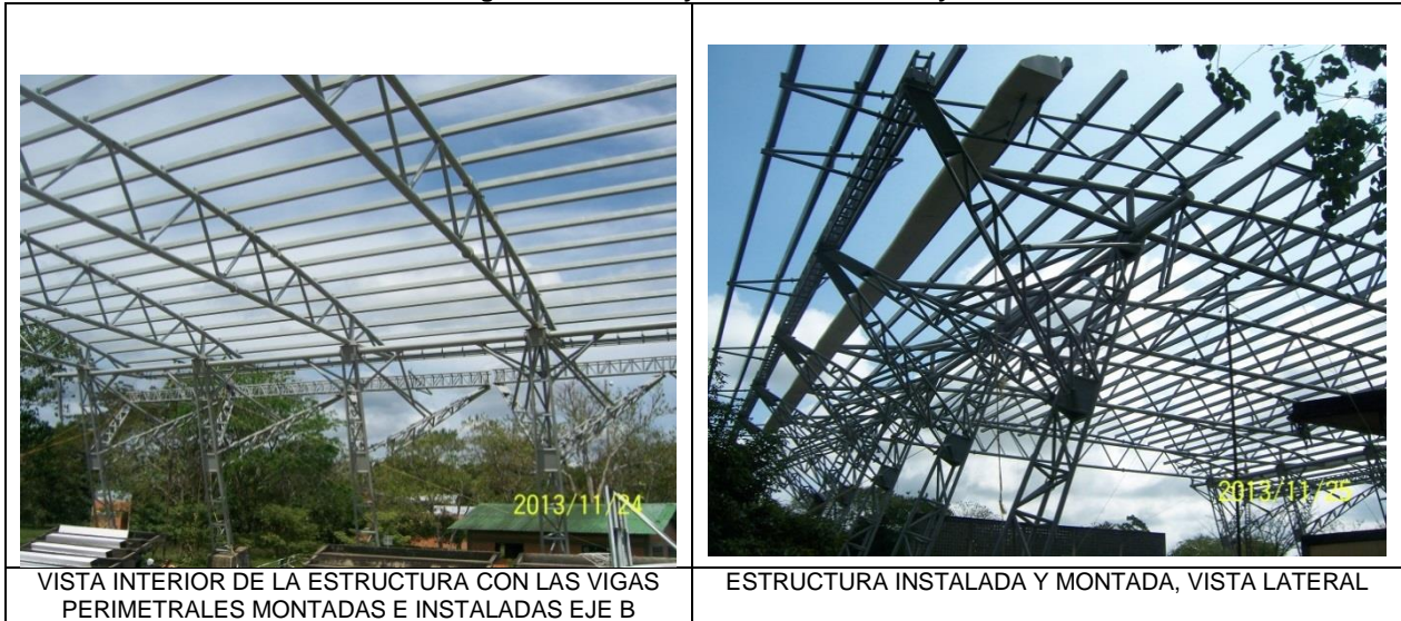
Ilustración 3. Vigas Perimetrales y Estructura Instalada y Montada
