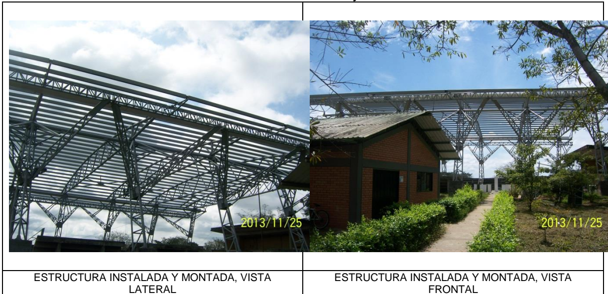
Ilustración 4. Estructura Lista y Montada
