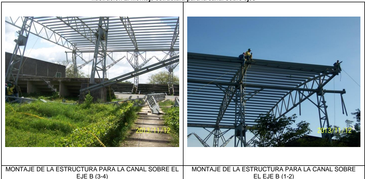
Ilustración 2. Montaje estructura para la canal sobre ejes
