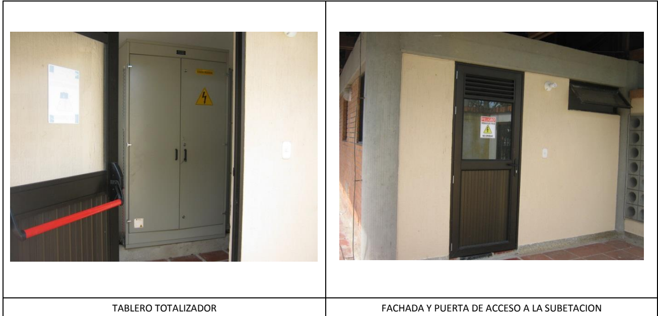
Ilustración 5. Adecuación y ampliación subestación eléctrica Sede Orinoquía
