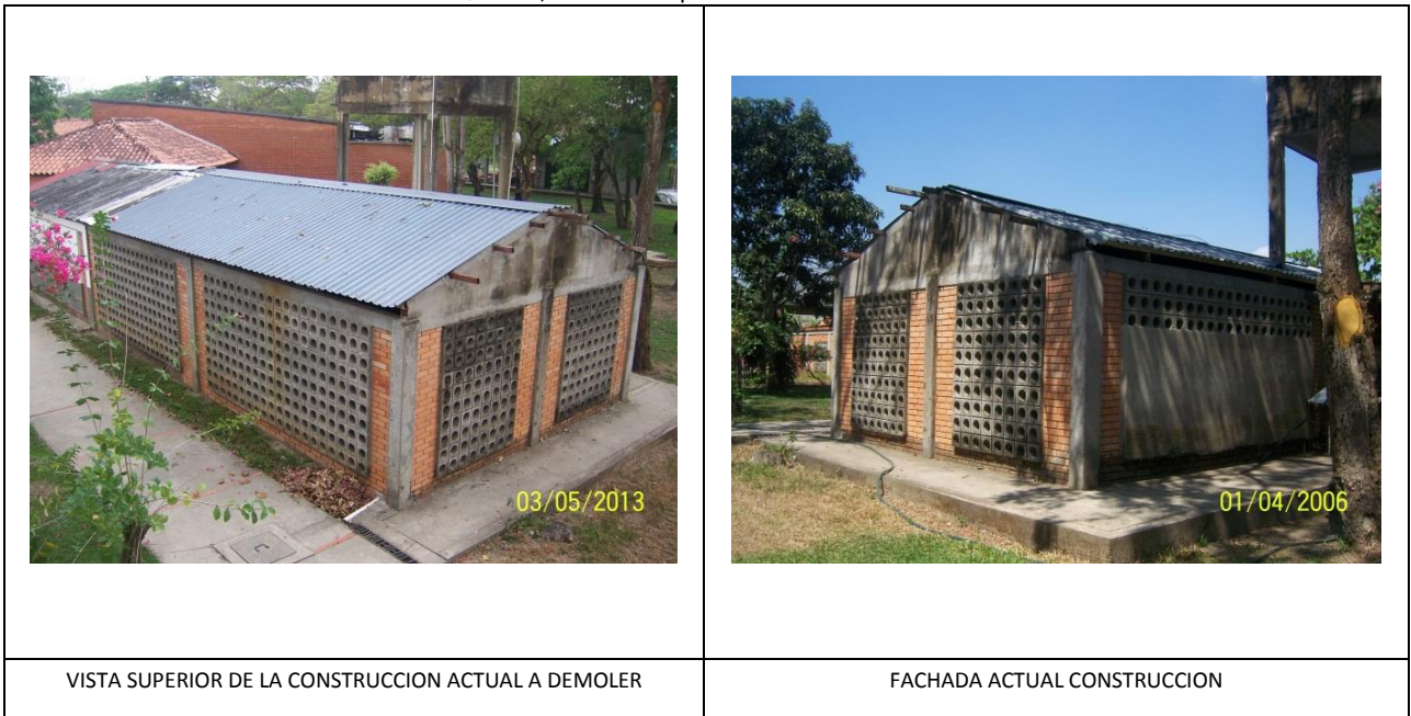
Ilustración 4. Construcción laboratorio de Química, Sede Orinoquía
