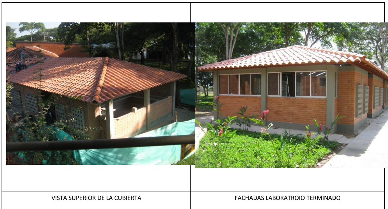
Ilustración 8. Construcción laboratorio de Química, Sede Orinoquía
