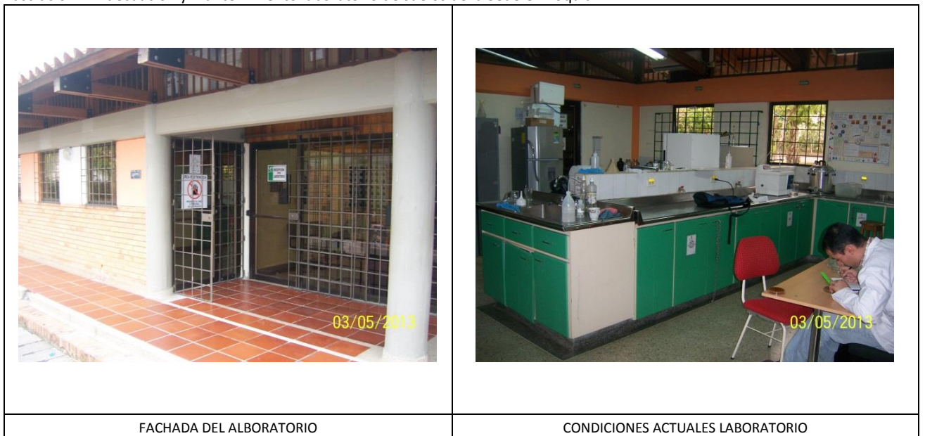
Ilustración 2. Adecuación y mantenimiento laboratorio de suelos de la Sede Orinoquía
