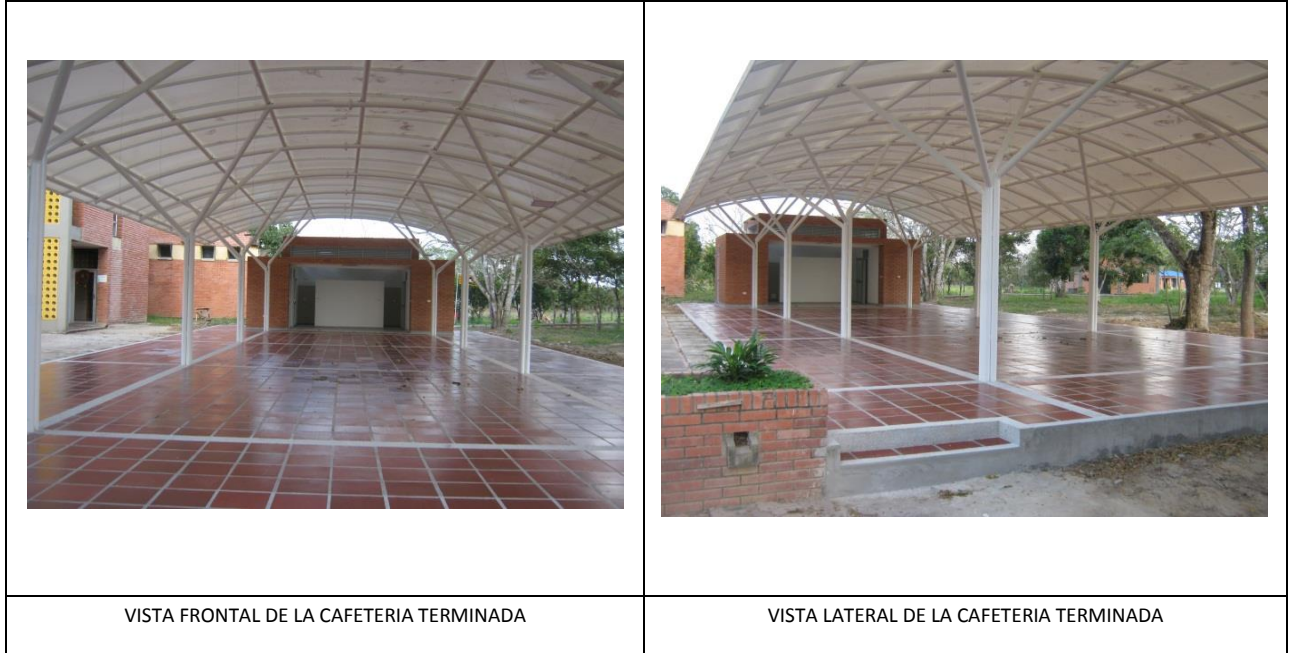
Ilustración 7. Construcción Cafetería Central, Sede Orinoquía
