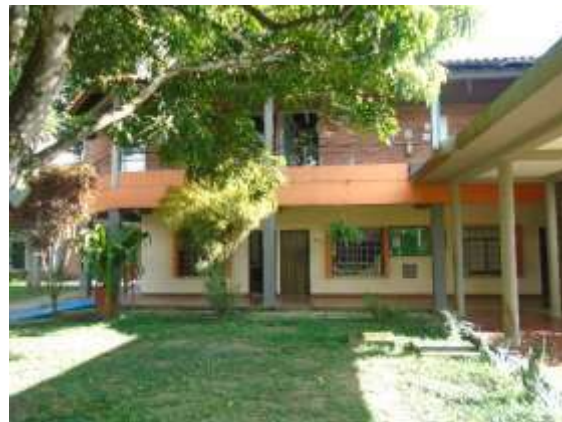
Fotografía 4. Vista Segundo Piso Renovado
