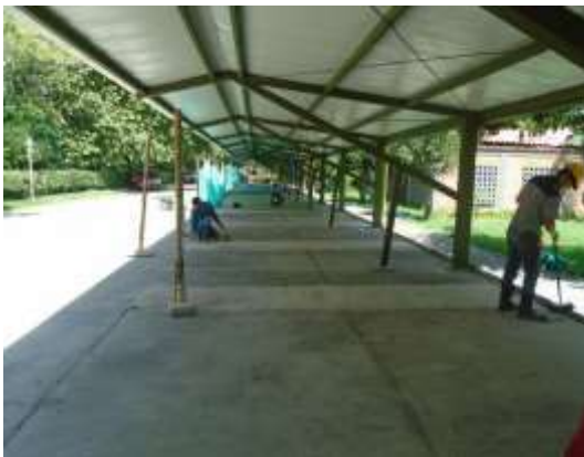
Fotografía 5. Parqueadero en Terminación
