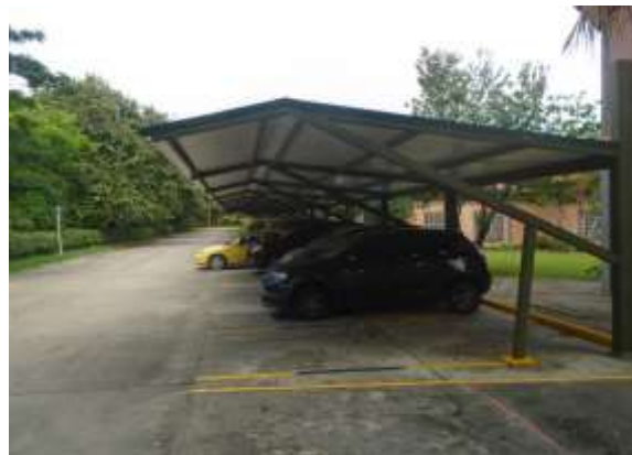
Fotografía 6. Parqueadero Terminado y en Uso.
